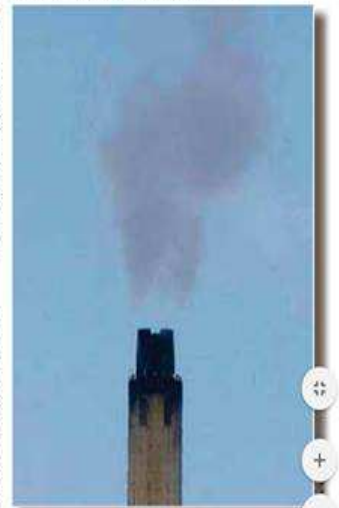
De schoorsteen van de BOO-energiecentrale die nu drie pijpen bestaat.
